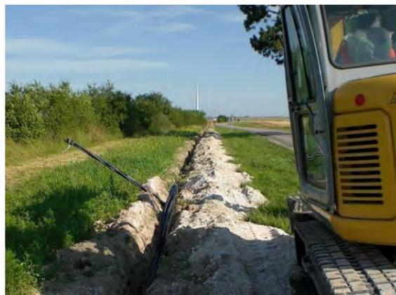
Photo 64 : Pose de câbles électriques et réalisation de tranchée à la pelle mécanique (Source : BE Jacquel et Chatillon)
