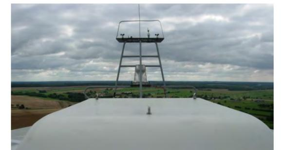
Photo 56 : Exemple d'anémomètre et girouette sur nacelle (Source : BE Jacquel et Chatillon)
