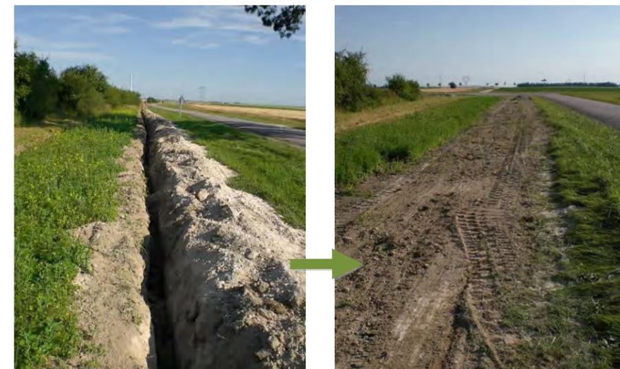
Photo 66 : Rebouchage de tranchée après passage des câbles électriques (Source : BE Jacquel et Chatillon)
