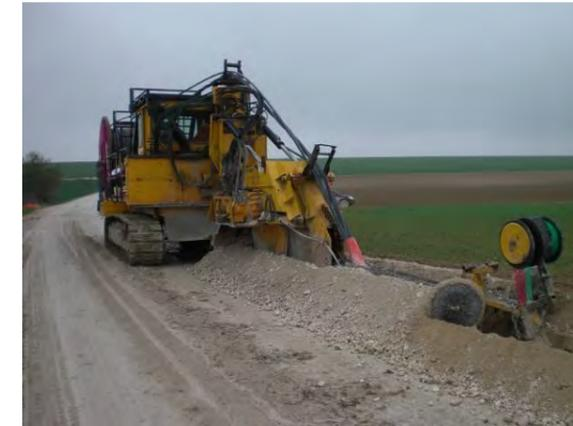
Photo 65 : Pose mécanisée de câbles électriques (Source : BE Jacquel et Chatillon)
