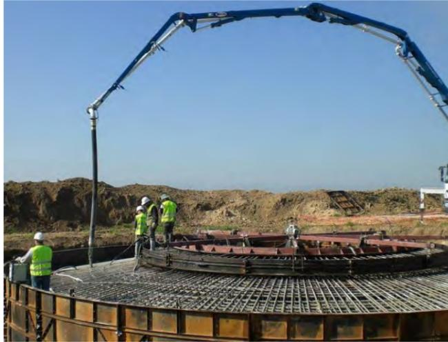
Photo 63 : Exemple de coulage du béton de fondation d'éolienne (Source : BE Jacquel et Chatillon)
