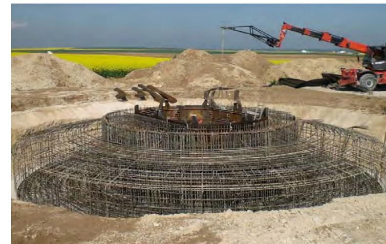
Photo 62 : Exemple de maillage d'acier d'armature pour fondation d'éoliennes de type massif poids (Source : BE Jacquelin et Chatillon)
