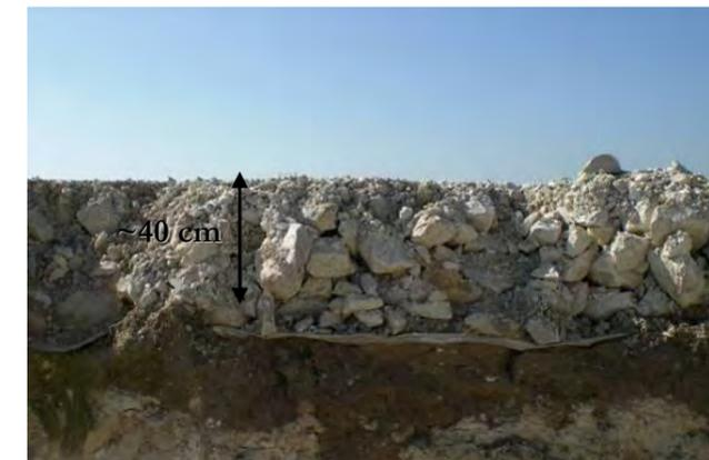
Photo 58 : Type de remblai utilisé pour le renforcement des chemins d'accès (Source : BE Jacquel et Chatillon)
