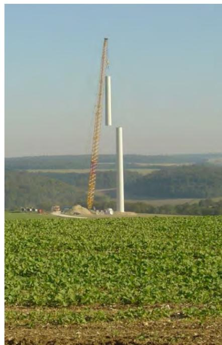
Photo 54 : Exemple d'assemblage d'un mât d'éolienne (Source : BE Jacquel et Chatillon)
